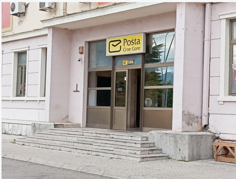
Slika 1. Pošta Crne Gore – primjer nepristupačnog objekta
